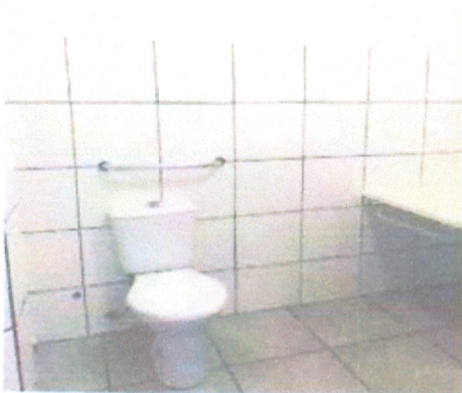
Banheiro com acessibilidade
